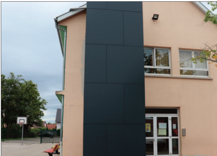
Début des travaux d'aménagement d'une cage d'ascenseur à l'école de la Strueth pour améliorer l'accessibilité du bâtiment.
