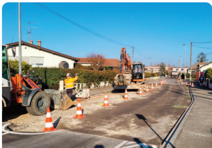
Les travaux de suppression d'un îlot central et de réfection de l'enrobé pour sécuriser la rue de Richwiller ont été réalisés début février.
