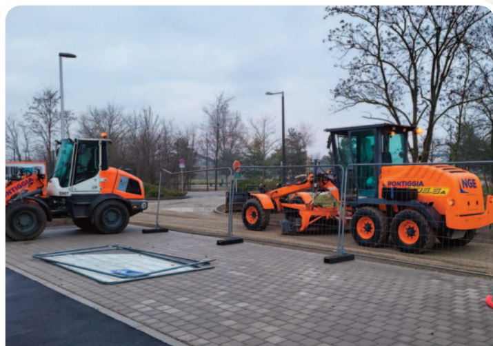
À partir du 10 février, des travaux de sécurisation de la voirie ont été entrepris dans la rue de Pfstatt, près du cimetière sud.
