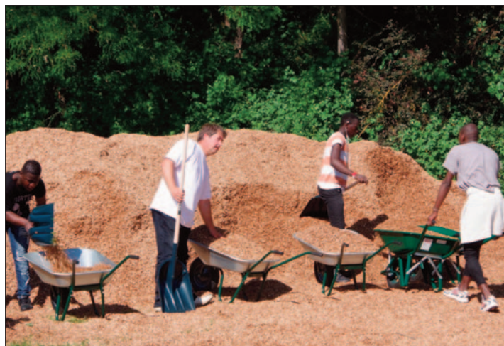
Les jeunes migrants hébergés dans l'hôtel social du Kaligone ont également voulu apporter leur part en prêtant main forte à un chantier de mise en place de copeaux sur l'aire du Bramont.
